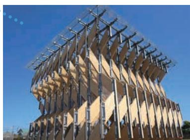
**CLTとは? >>>**ひき板を繊維方向が直交するように積層接着した重厚な木製パネルで、厚みや幅があるため、高い断熱性や耐火性、強度が期待できます。
