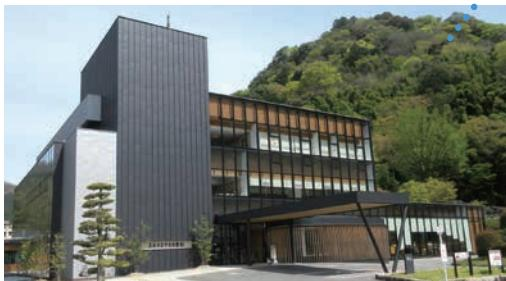
勝山振興局(庁舎)を中央図書館に用途変更し、内部の間仕切り壁にCLTを使用。冷暖房設備はバイオマスボイラーを使用しています。既存躯体の約80%を再利用しながら、建替えの約70%のコストで設備一新できるリファイニング建築を採用。
